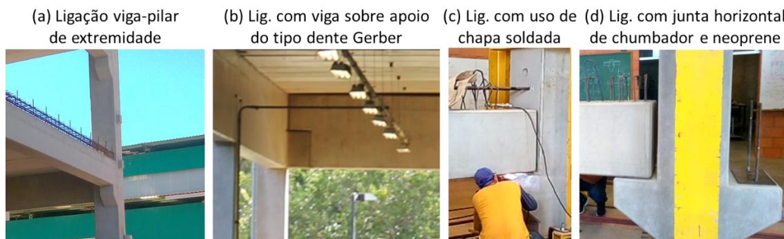
Figura 1.2: Diferentes tipos de ligações viga-pilar
