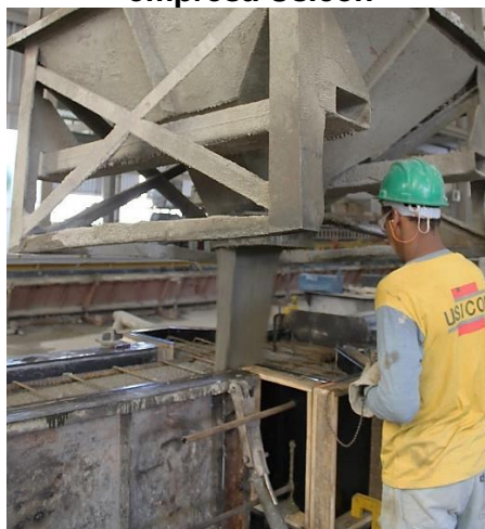
Figura 3.22: Lançamento de concreto na forma de um dos pilares no pátio da empresa Usicon
