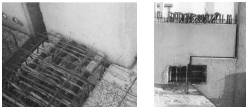
Figura 2.39: Detalhe das emendas mecânicas utilizadas por empresa Portuguesa
