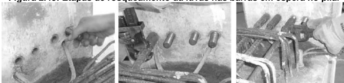
Figura 2.43: Etapas de rosqueamento da luvas nas barras em espera no pilar
