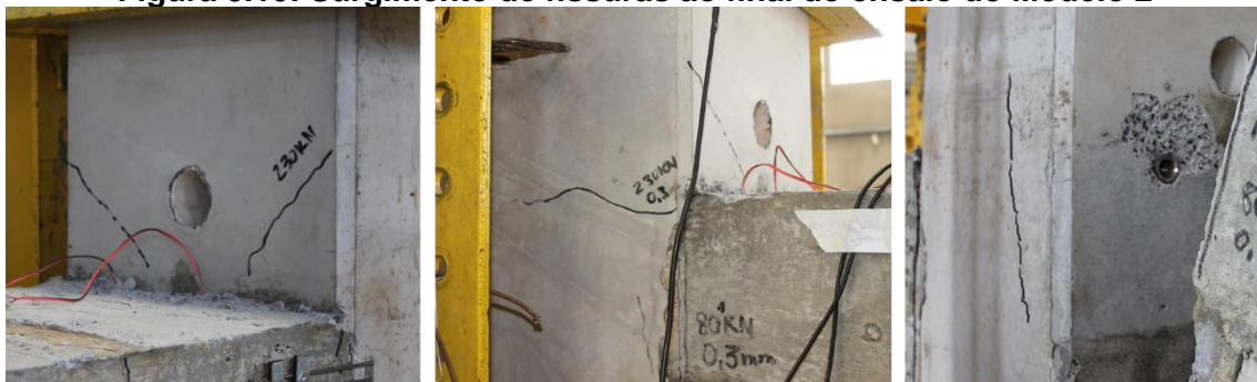
Figura 5.10: Surgimento de fissuras ao final do ensaio do Modelo 2
