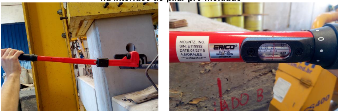
Figura 4.17: Torquímetro utilizado para rosquear as barras nas luvas em espera na interface do pilar pré-moldado
