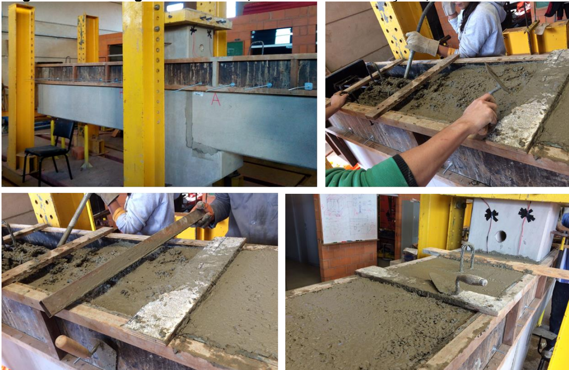
Figura C.7: Montagem das fôrmas, concreto sendo lançado, vibrado e acabado
