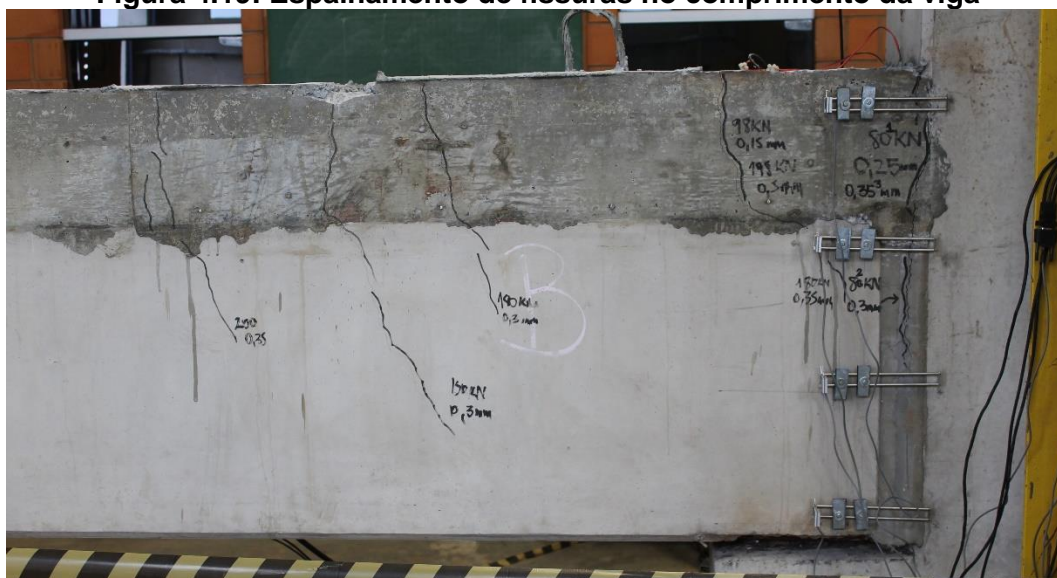
Figura 4.19: Espalhamento de fissuras no comprimento da viga
