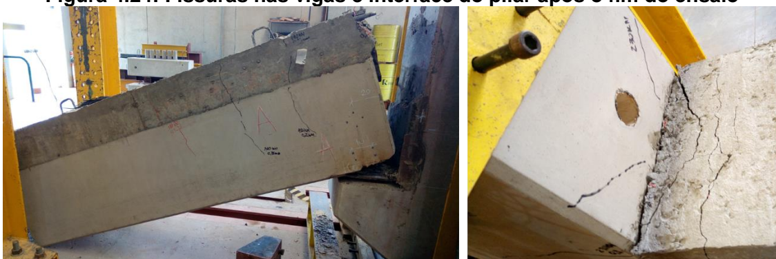
Figura 4.24: Fissuras nas vigas e interface do pilar após o fim do ensaio
