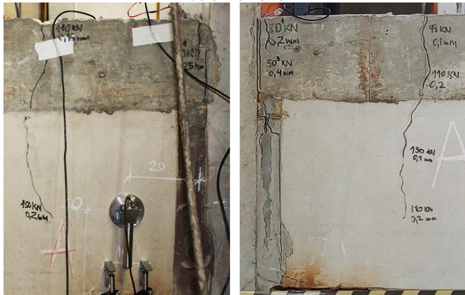
Figura 5.5: Fissuras em ambos os lados da viga A situadas logo após a posição do clinômetro
