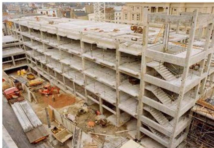
**Figura 2.2: Exemplo de estrutura pré-moldada em esqueleto para múltiplos pavimentos [FIB (2003)].**
