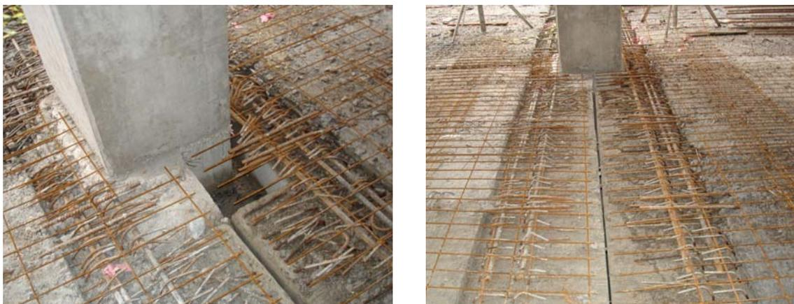
**Figura 2.12: Ligação com armadura de continuidade nas laterais do pilar [CPI ENGENHARIA (2006)].**
