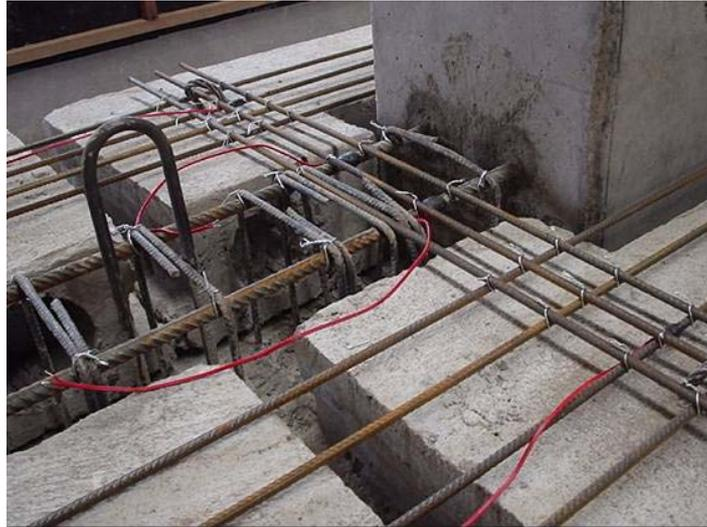
**Figura 3.19:** Posicionamento das armaduras na capa da laje alveolar.
