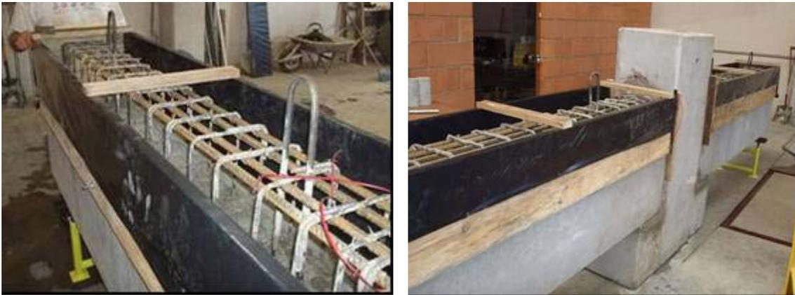
Figura 3.14: Montagem da fôrma do Modelo 1.
