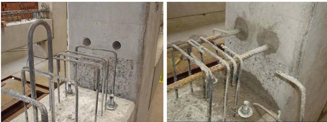
**Figura 3.16: Preenchimento da interface e da bainha com graute.**
