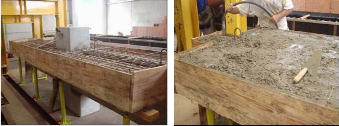
**Figura 3.21: Fôrmas e concretagem do Modelo 2.**
