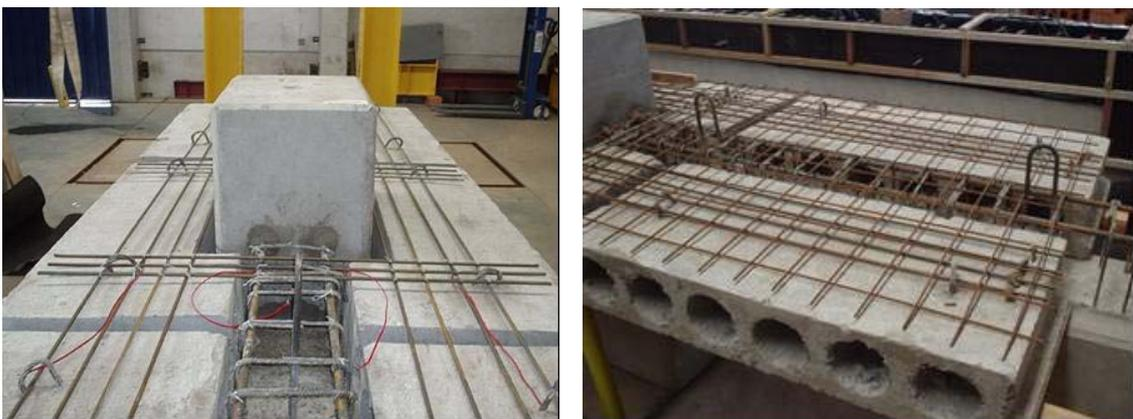
**Figura 3.18: Posicionamento das armaduras na capa da laje alveolar.**
