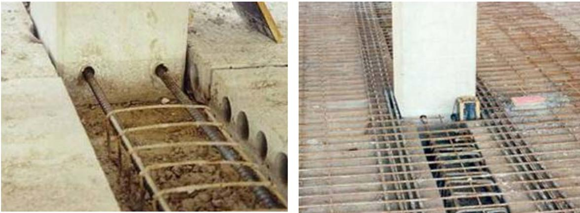
**Figura 2.11: Armadura de continuidade passando dentro e ao lado do pilar. [BENTES (2004)].**
