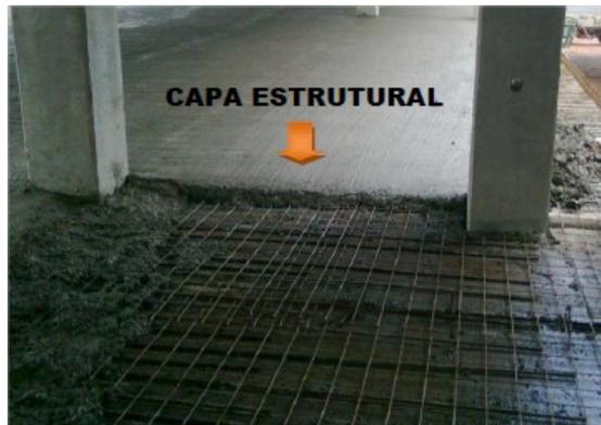
Figura 35 – Execução de capa estrutural sobre a laje alveolar (Fonte: Antunes, 2011)
