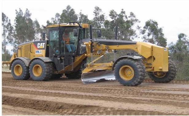
Figura 20 – Nivelamento do terreno (Fonte: Direitinho, 2014)
