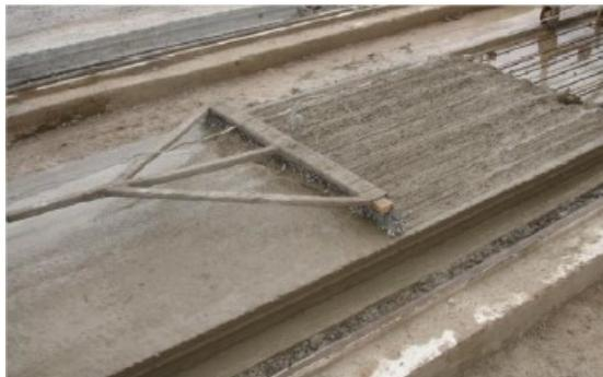
Figura 31 – Execução de superfície rugosa durante a concretagem (Fonte: Antunes, 2011)
