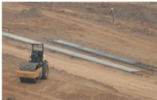
Figura 21 – Execução dos leitos das pistas de protensão (Fonte: Direitinho, 2014)
