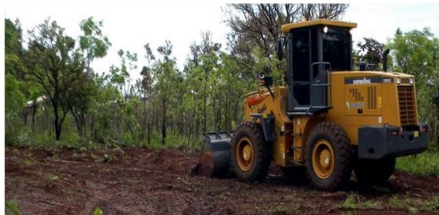
Figura 19 – Limpeza e desmatamento do terreno (Fonte: Direitinho, 2014)
