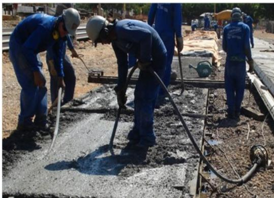
Figura 26 – Concretagem e vibração (Fonte: Direitinho, 2014)
