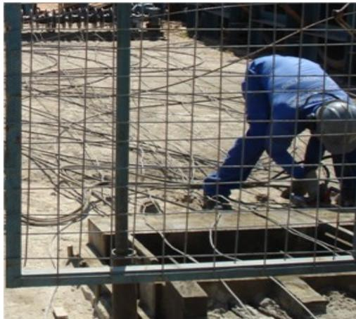
Figura 25 – Protensão dos cabos (Fonte: Direitinho, 2014)
