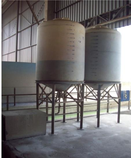
Figura 45 – Armazenamento/estocagem de aditivos em silos de material polimérico
