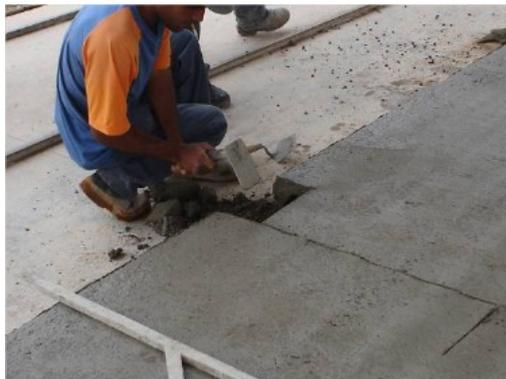
Figura 12 – Execução de um recorte de pilar em concreto fresco (Fonte: Petrucelli, 2009)
