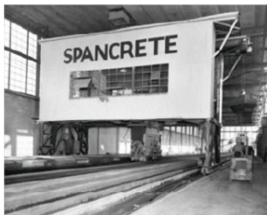
Figura 1 – Máquina de concretagem sob uma ponte rolante (Fonte: PCI, 2005)
