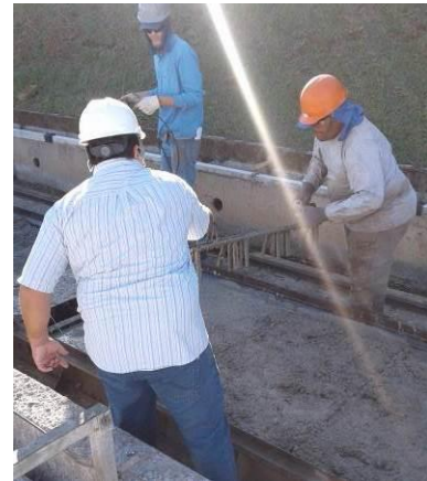
Figura 5-37: a) adensamento do concreto nas nervuras e da borda superior da laje b) remoção das “barras” de fixação do EPS
