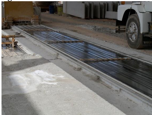
Figura 5-17: Posicionamento dos sarrafos
