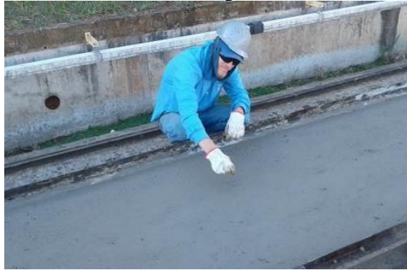
Figura 5-39: Método utilizado para aferir a altura da laje
