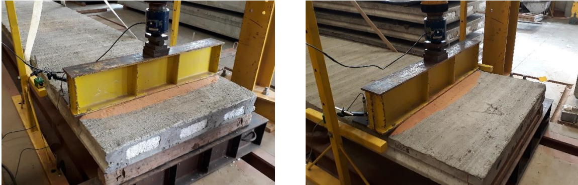
Figura 6-3: Regularização da superfície das lajes na região de contato com a viga de transmissão
