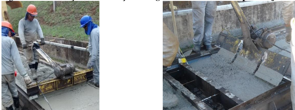
Figura 7-37: Variação da inclinação da régua vibratória com o topo da laje
