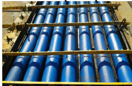
Figura 5-5: Fôrma contendo tubos de plástico preenchidos por ar comprimido
