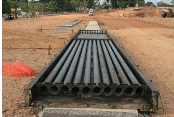
Figura 5-6: Fôrma contendo tubos de aço
