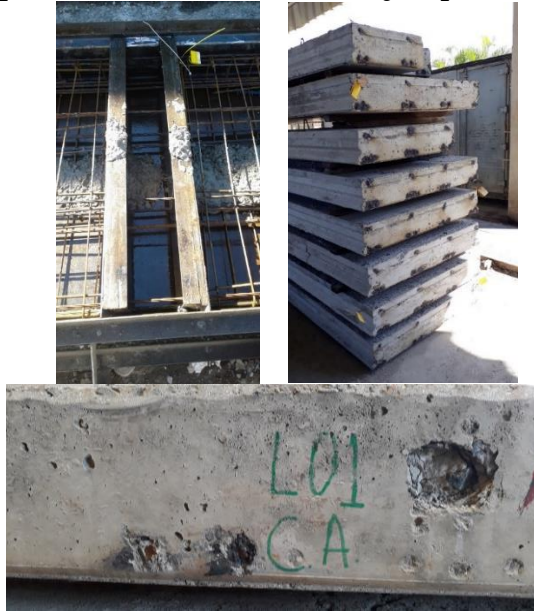
Figura 7-20: Topadores e a extremidade das lajes após o corte da cordoalha
