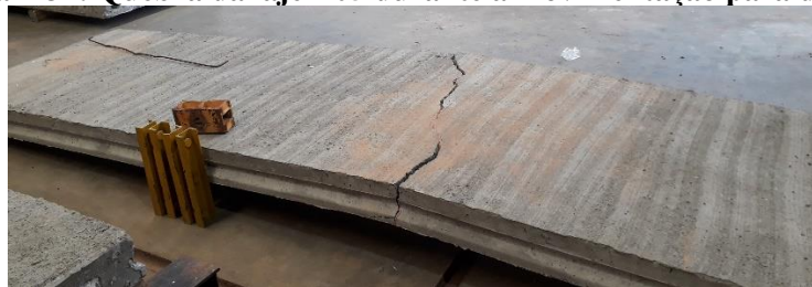
Figura 7-34: Quebra da laje L05 durante a movimentação para descarte
