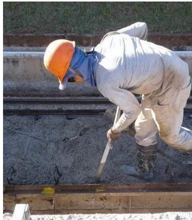
Figura 5-37: a) adensamento do concreto nas nervuras e da borda superior da laje b) remoção das “barras” de fixação do EPS
