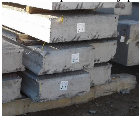
Figura 5-52: Laje alveolar moldada por fôrma fixa já produzida com o recorte
