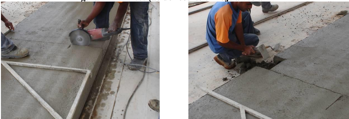
Figura 5-42: Execução de recorte em laje alveolar
