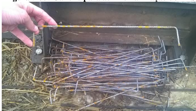
Figura 5-33: Gancho para auxílio na fixação do EPS
