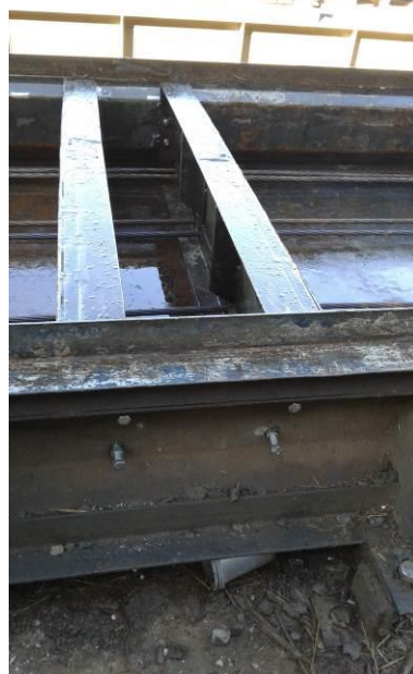
Figura 5-12: Fixação das tampas extremas nas fôrmas laterais
