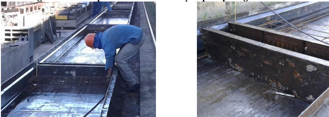
Figura 5-20: Tampas extremas com furações para passagem da cordoalha
