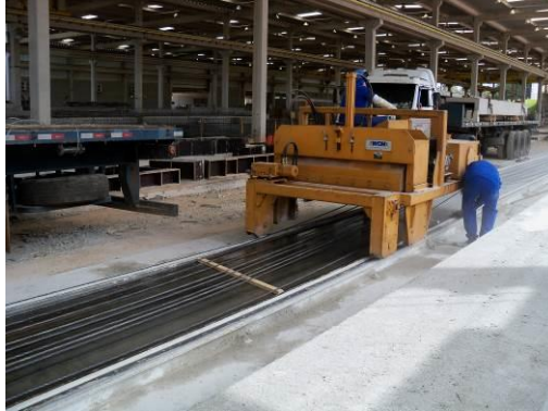
Figura 5-16: Aplicação de desmoldante por meio de equipamento
