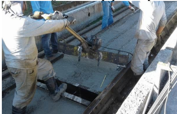
Figura 5-38: Equipamento para dar acabamento a parte superior da laje
