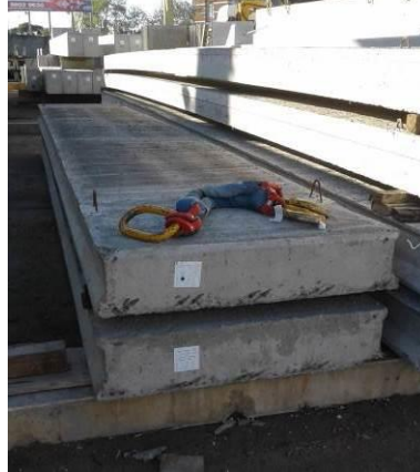
Figura 5-60: Estocagem de laje alveolar moldada por fôrma fixa
