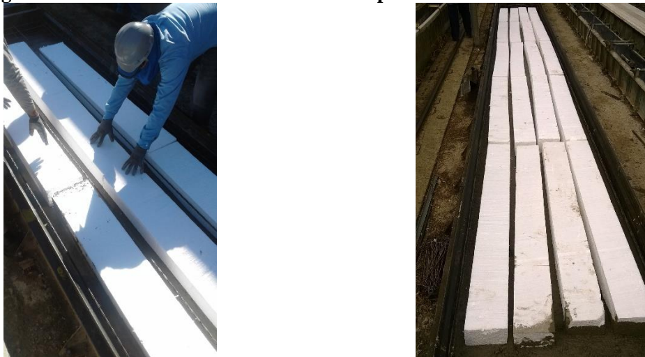
Figura 5-31: Posicionamento do EPS sobre a primeira camada de concreto
