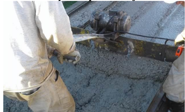
Figura 5-38: Equipamento para dar acabamento a parte superior da laje
