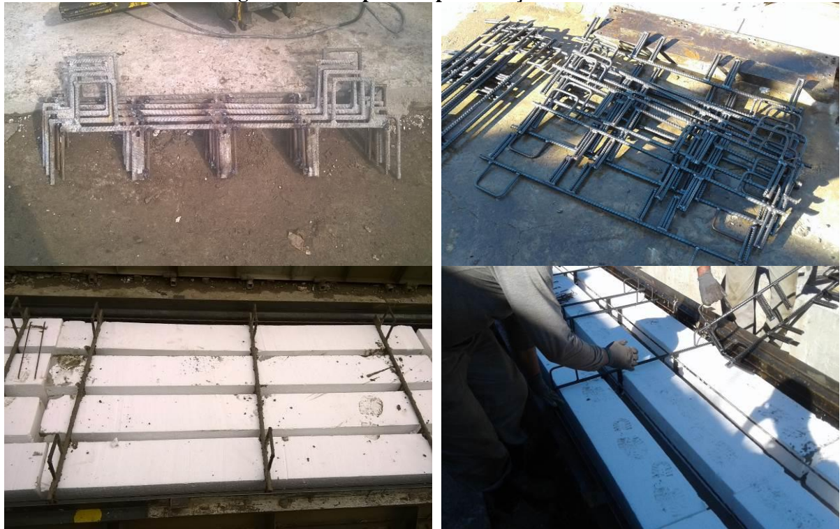
Figura 5-32: Dispositivo para fixação do EPS
