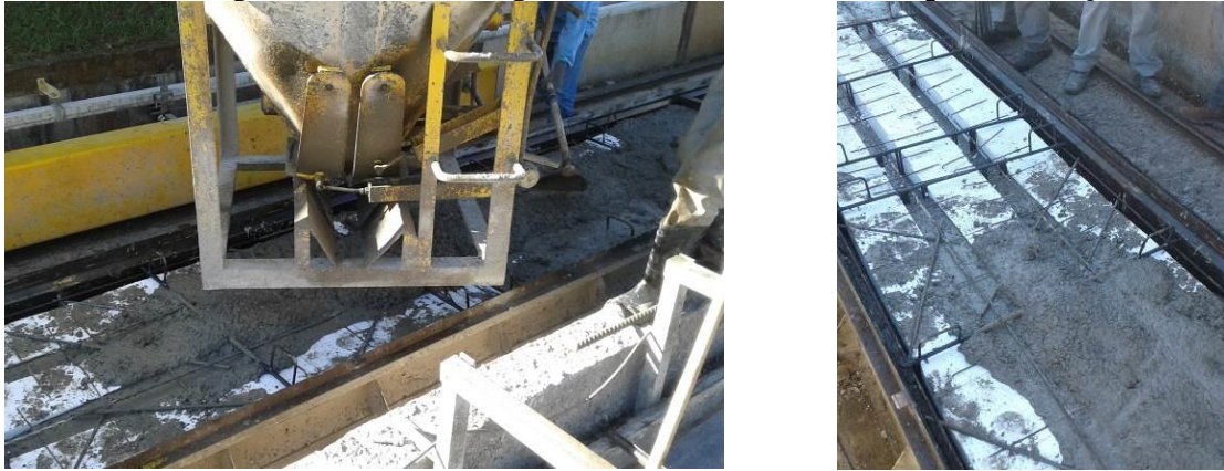
Figura 5-35: Concretagem da nervura e da borda superior da laje
