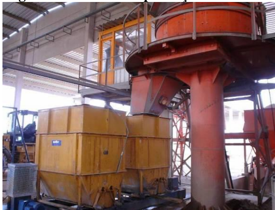
Figura 5-25: Usina de produção de concreto
