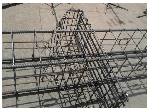
FIGURA 3.3 – Armadura e forma dos pilares para todos os modelos
