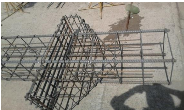
FIGURA 3.3 – Armadura e forma dos pilares para todos os modelos
