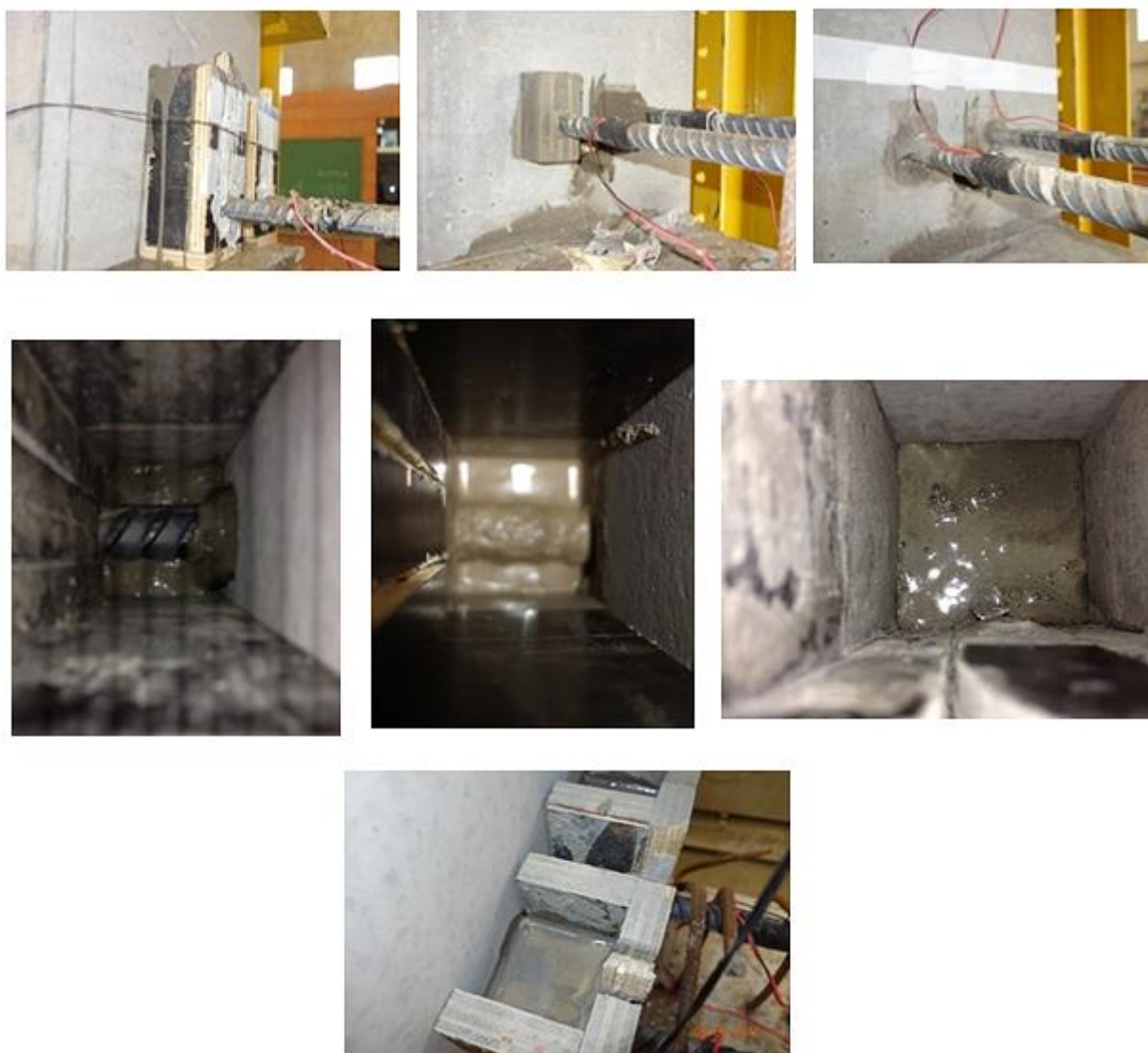
FIGURA 3.28 – Preenchimento com graute dos nichos das barras de continuidade utilizando-se a técnica dos vasos comunicantes
