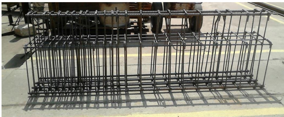
FIGURA 3.12 – Armadura e forma das pré-vigas para todos os modelos
