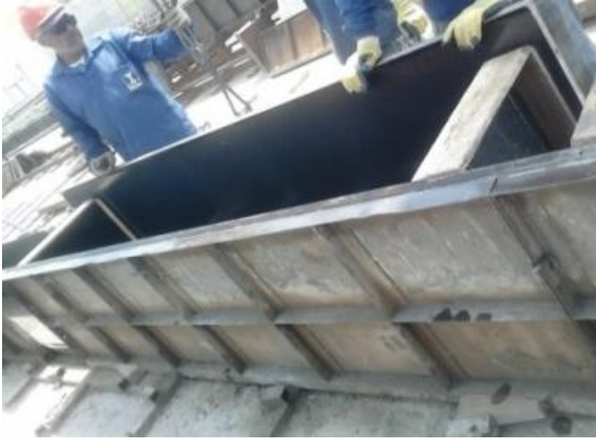
FIGURA 3.11 – Forma das pré-vigas para todos os modelos
