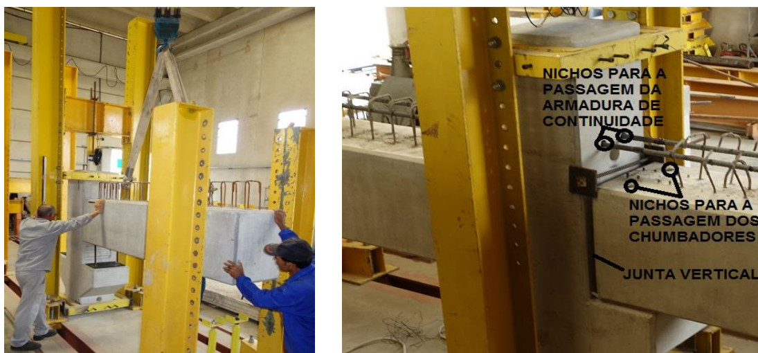
FIGURA 3.10 – Montagem da estrutura
