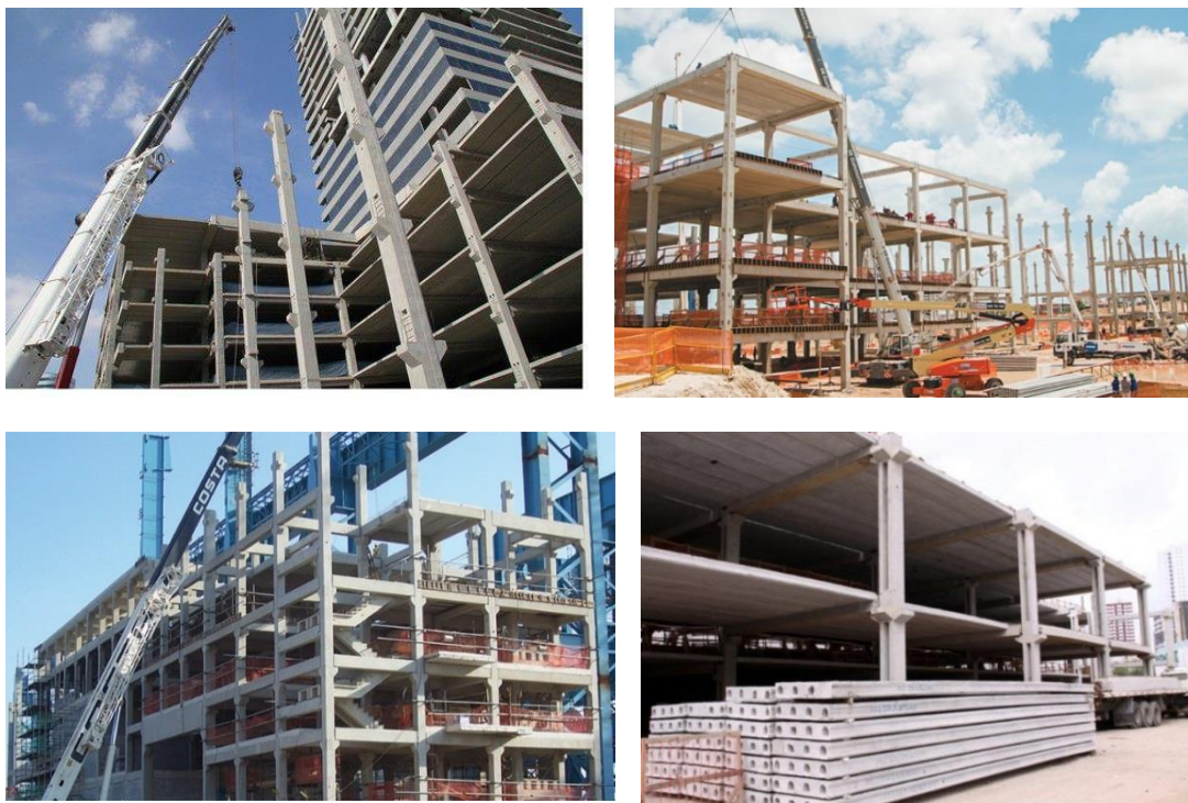
FIGURA 2.8 – T&A Pré-fabricados – Estruturas em esqueleto
