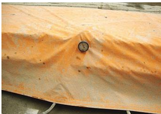
FIGURA 3.26 – Peça em concreto pré-fabricado em processo de cura a vapor
